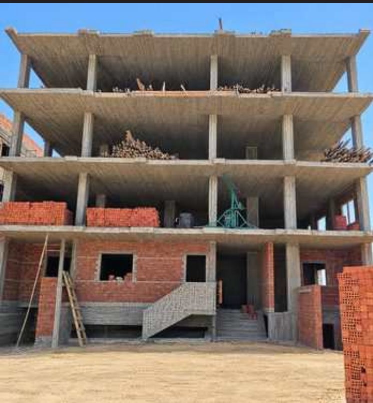
03 Concrete frame الهيكل الخرساني
