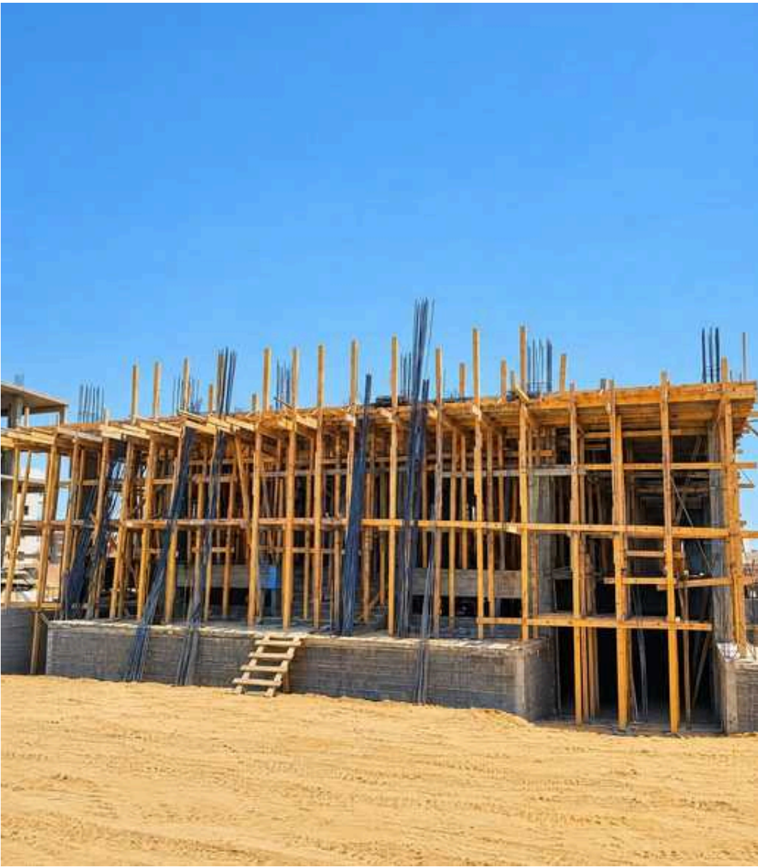
Plot 105 i 2nd District, Beit El Watan Formwork and reinforcement for the ground-floor slab. نجارة وحدادة سقف الدور الأرضي.
