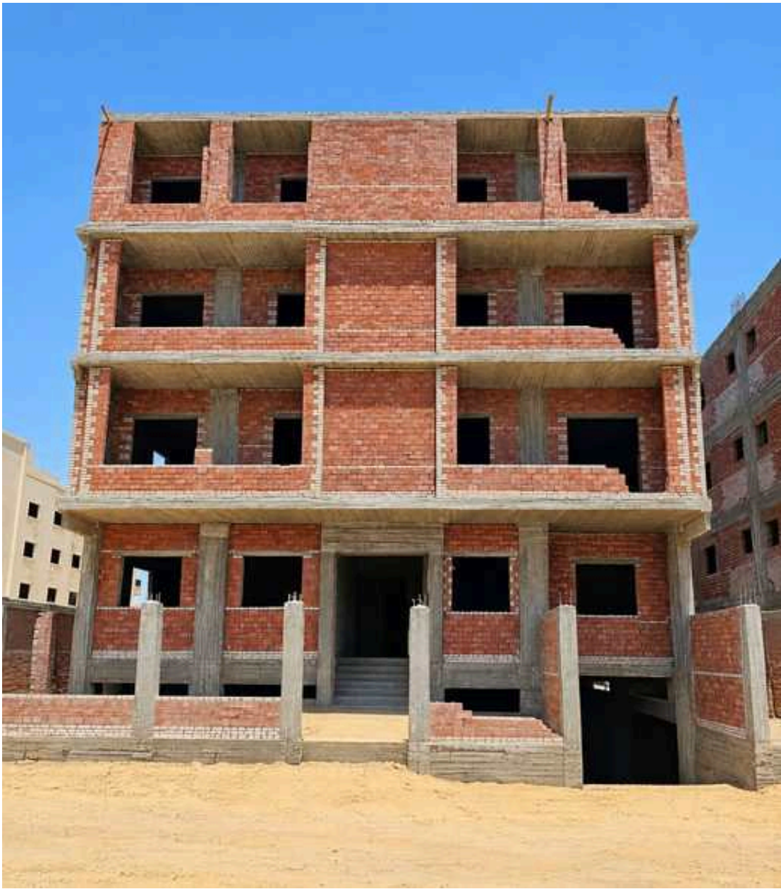
Plots 4 and 5 G 3rd District, Beit El Watan Structure and brickwork complete; ready for plaster. اكتمل الهيكل وأعمال المباني، وجاهزة للمحارة.
