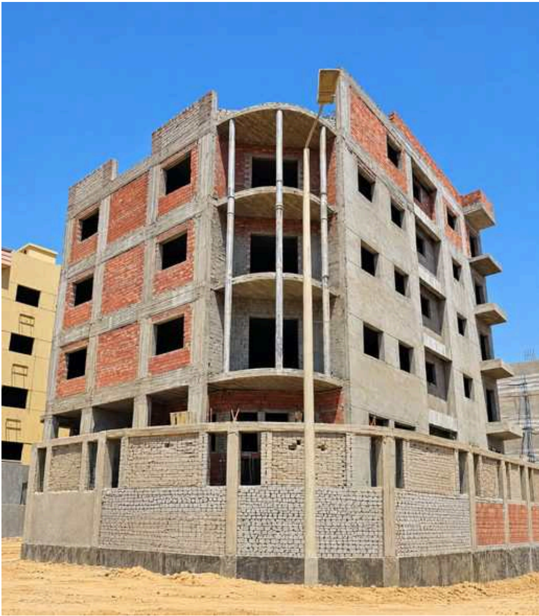
Plot 29A 6th District, Beit El Watan Corner building with a curved bay; brickwork and plaster under way. عمارة على ناصية بواجهة منحنية، أعمال المباني والمحارة جارية.
