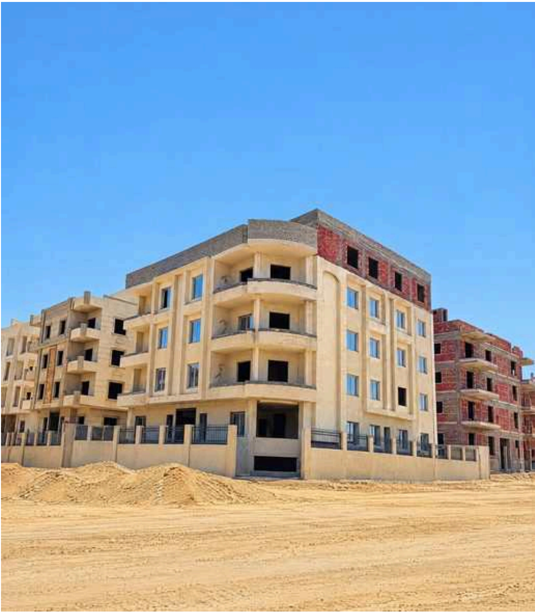
Plot 63A 6th District, Beit El Watan Corner building with curved balconies; facade plaster and paint complete. عمارة على ناصية بشرفات منحنية، اكتملت محارة الواجهة ودهانها.
